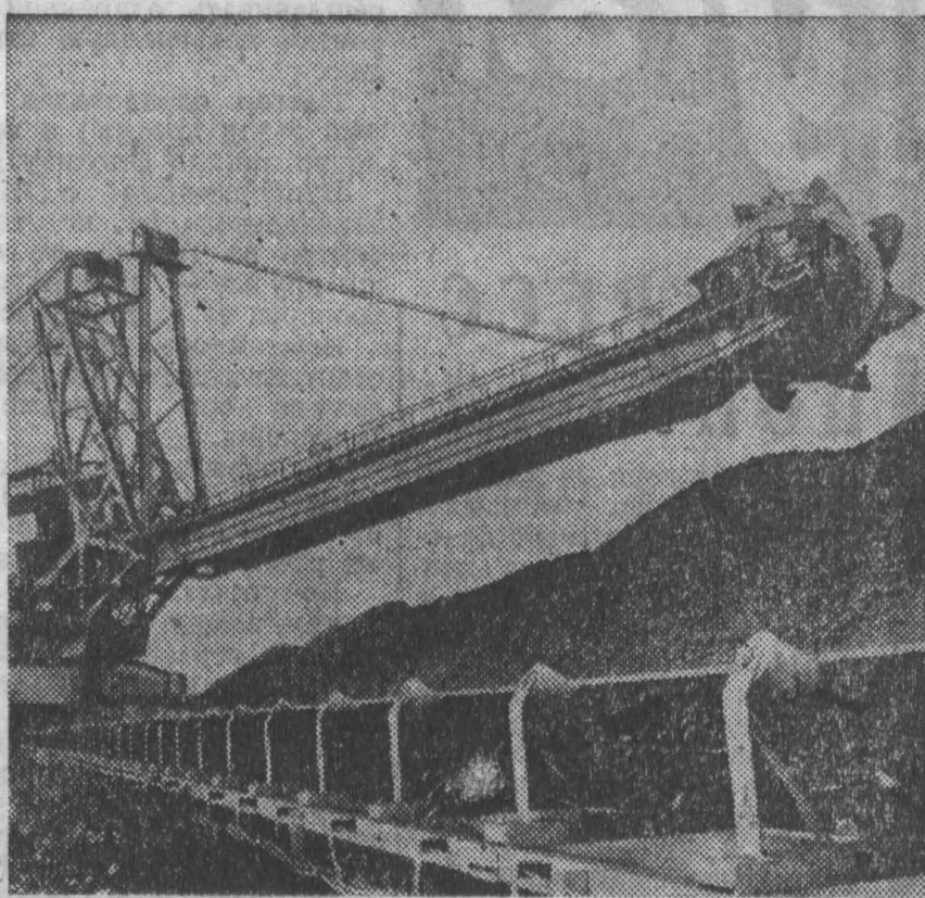
Социалистическая республика Румыния. На разработках в угольном бассейне Ровинари широко применяется сейчас самая совершенная техника. Недавно здесь смонтирован мощный экскаватор (на снимке), заменяющий работу трех тысяч человек.
