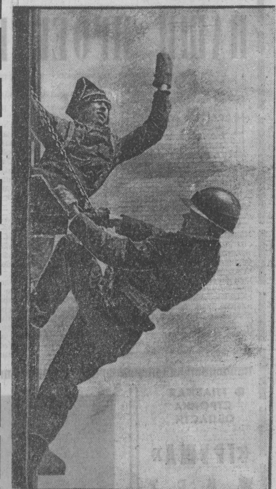
Монтажники Юрий Сузик и Владимир Танков. Этим парнем хорошо знают на строительстве седьмой очереди Кемеровской ГРЭС как работающих людей, как отличных товарищей. г. Кемерово. Фото В. Грызыхина.
