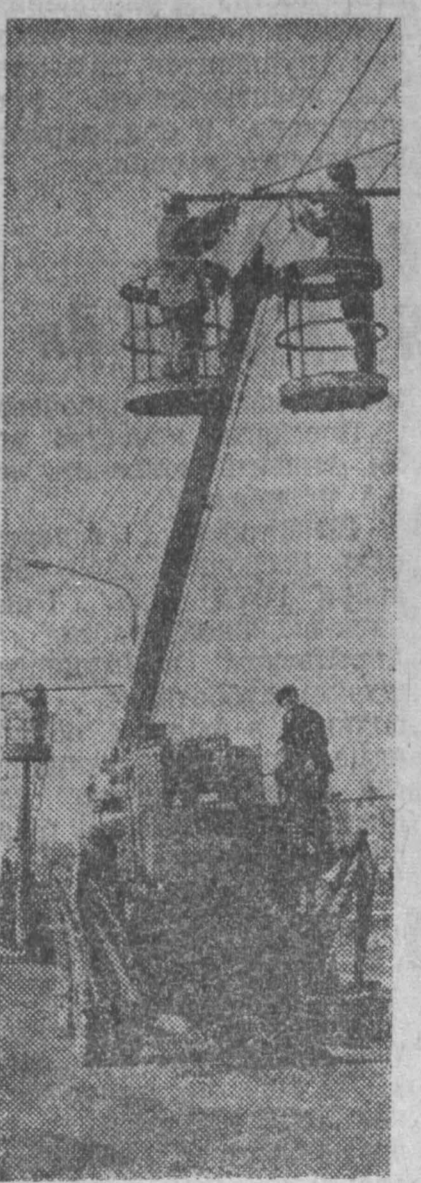
Совсем недавно мы были свидетелями пуски первой очереди нового вида транспорта в Кемерове — троллейбуса. Затем следом в эксплуатацию вошли маршруты А и Б. В эти дни монтажные бригады Василия Дмитриевича Никифорова из ИСУ-1 треста «Немороховавтокомонтаж» заканчивают монтаж контактного провода на продолжении проспекта имени Ленина.
