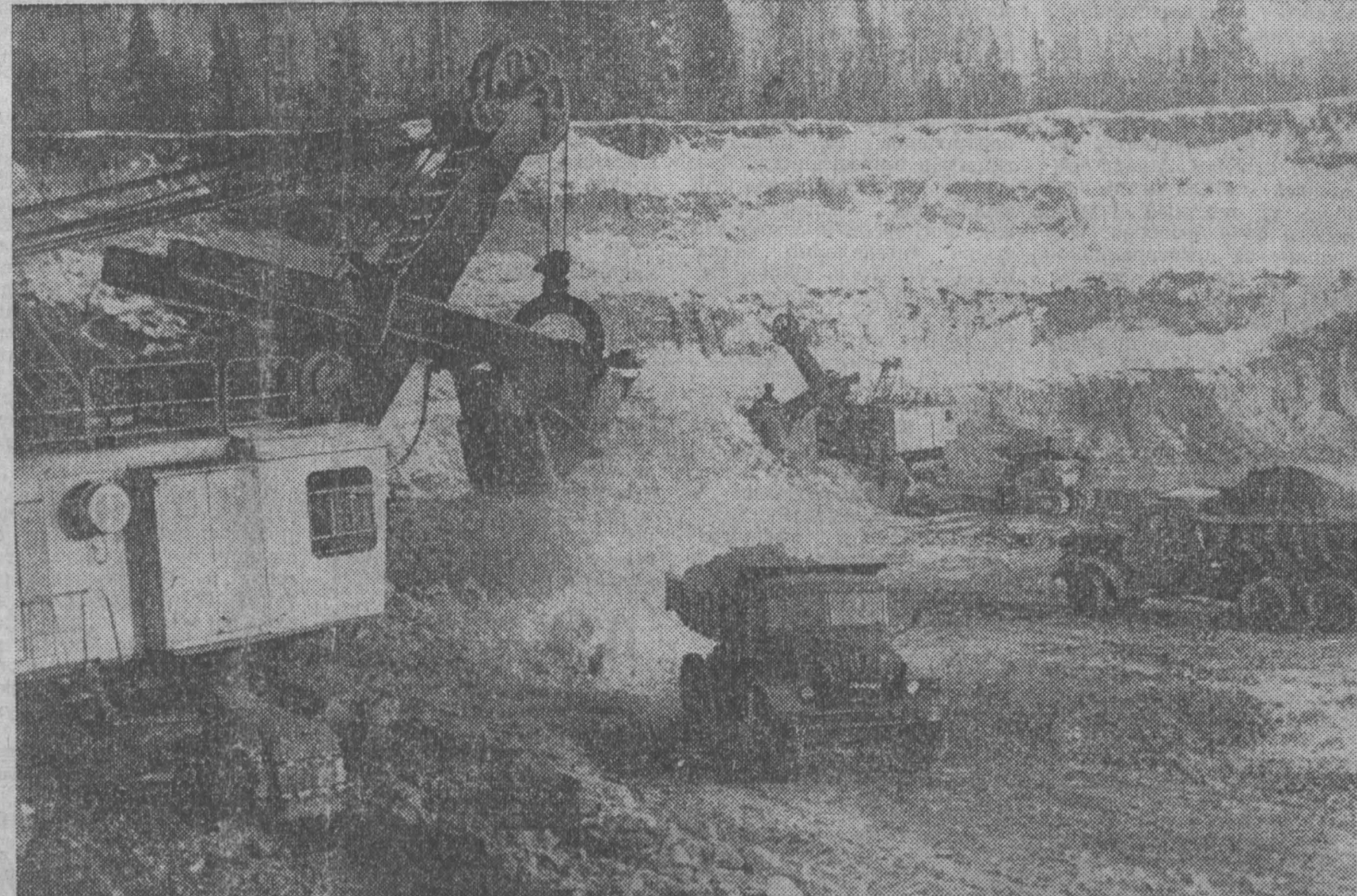
ПОДХОДЯТ к концу вскрышные работы на строительстве Новокузнецкого разреза — объекта, записанного в Директивах XXIV съезда КПСС. Здесь уже поднят свыше 3,5 миллиона кубометров горной массы. Длина разрезной трассы к настоящему времени составила 1,200 м.
