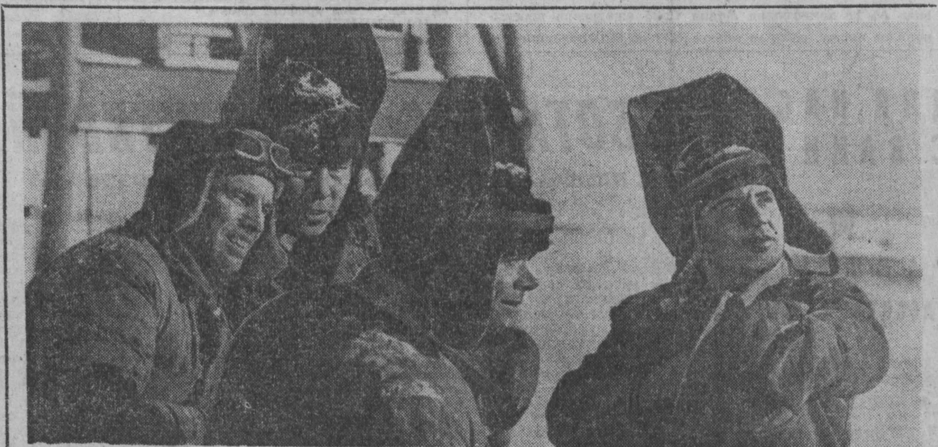
Бригада монтажников А. С. Куприянова в строительном управлении № 5 треста «Кемероуголестрой» считается одной из лучших. Их руками отстроены десятки самых различных объектов. Сейчас монтажники заняты на строительстве административного корпуса комбината шелковых тканей. На 120—130 проц. ежемесячно выполняется производственная программа. Коллектив возглавляет бригадир А. С. Куприянов.
