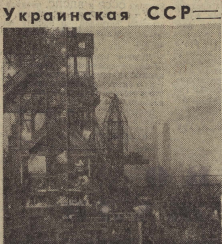
Доменщики запорожского металлургического завода «Запорожсталь» работают со значительным опережением графика. Набирает производственные мощности третья доменная печь после полной ее реконструкции. НА СНИМКЕ: вид на третью доменную печь вечером.
