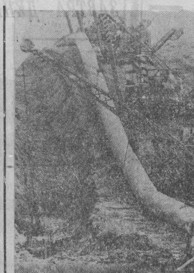
● ГЕРМАНСКАЯ ДЕМОКРАТИЧЕСКАЯ РЕСПУБЛИКА. Быстро продвигаются работы по сооружению трубопровода, по которому в недалеком будущем пойдет советский природный газ. Уже в первом квартале 1973 года он начнет поступать на крупнейший химический комбинат «Лейпциг». В ходе строительства предстоит проложить многие километры труб.
