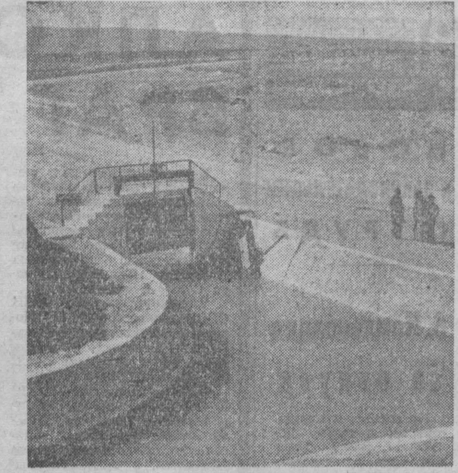
Советский Союз оказывает Афганистану большую помощь в освоении засушливых земель. Совместный труд афганских и советских специалистов преобразил многие районы страны. На негодных пустынных землях засеяны сады, орошенные земли покрылись плантациями оливковых и цитрусовых культур. НА СНИМКЕ: магистральный канал в Сарде. Фотохроника ТАСС.
