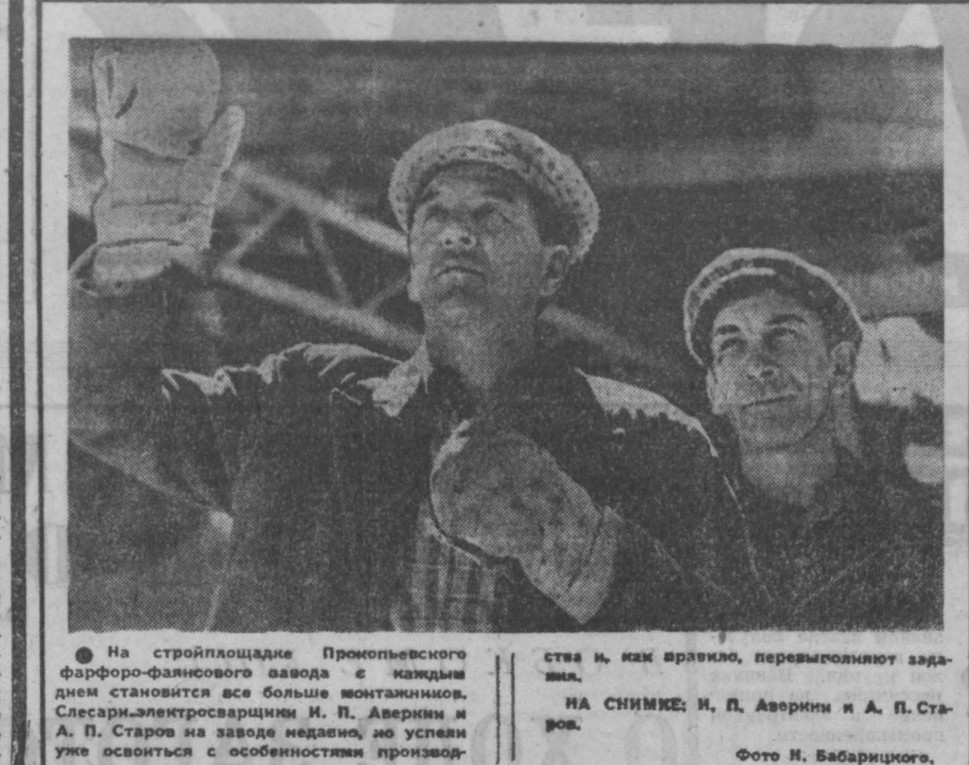
На стройплощадке Прокпьевского фарфоро-фаянсового завода с нарядом становится все больше монтажников. Слева — электростроитель И. П. Аверин и А. П. Старов на заводе нарядов, но успев уже освоиться с особенностями производ...
