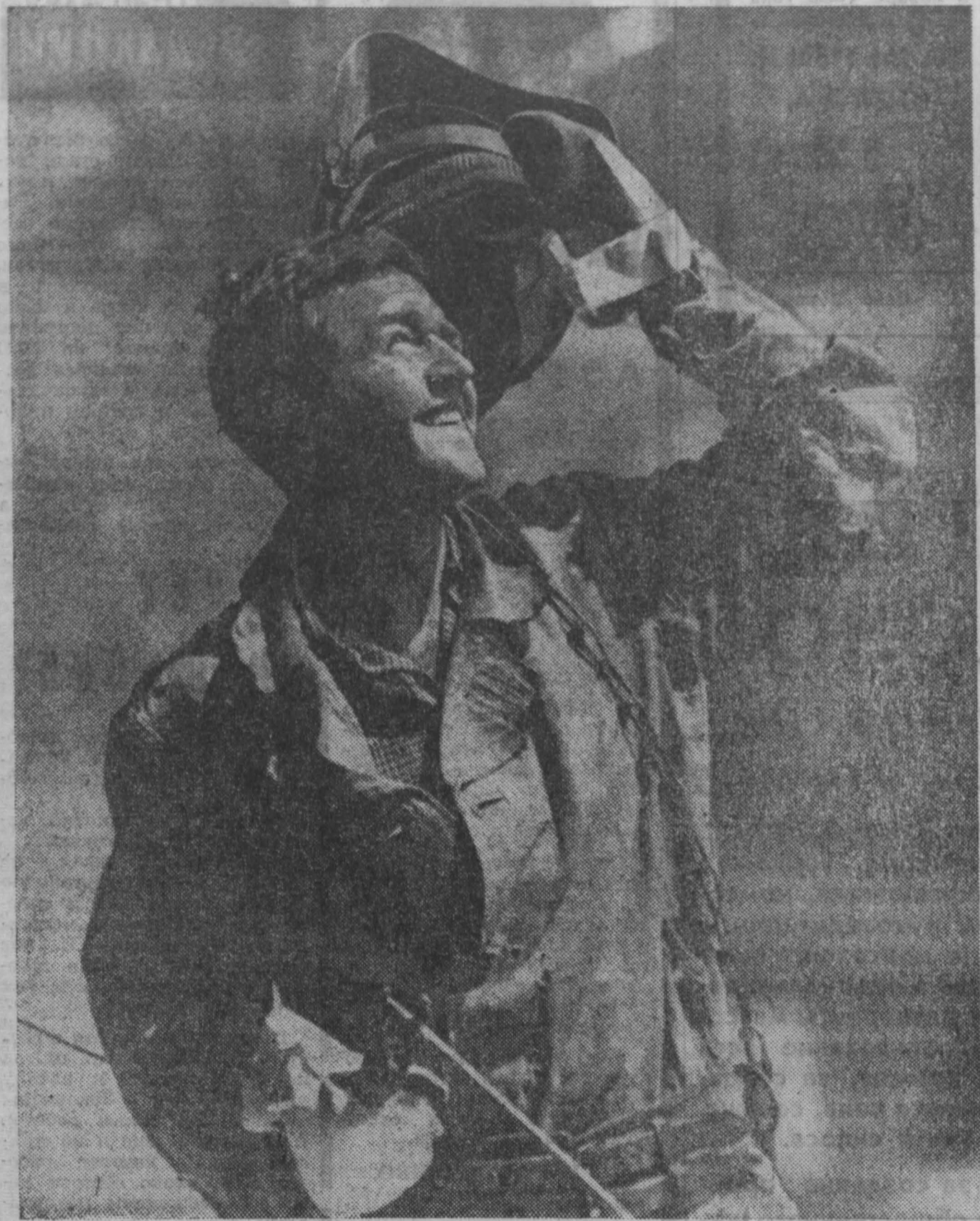
Комсомолец Александр Демьяновский — монтажник. Он строит горно-металлургический корпус Сибирского металлургического института...
