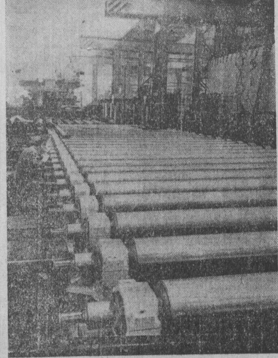
СССР. В цехах предприятия «Шкода» в Пльзене идет сборка оборудования для гигантского прокатного стана «Кварто-3600» (на снимке), который строится по заказу Советского Союза на Витповицком комбинате «Кварто-3600», вес которого достигает десятков тысяч тонн, называемый «экскаватор столетия». Большинство узлов стана-гиганта уже доставлено в СССР. Фото ЧТК — ТАСС.
