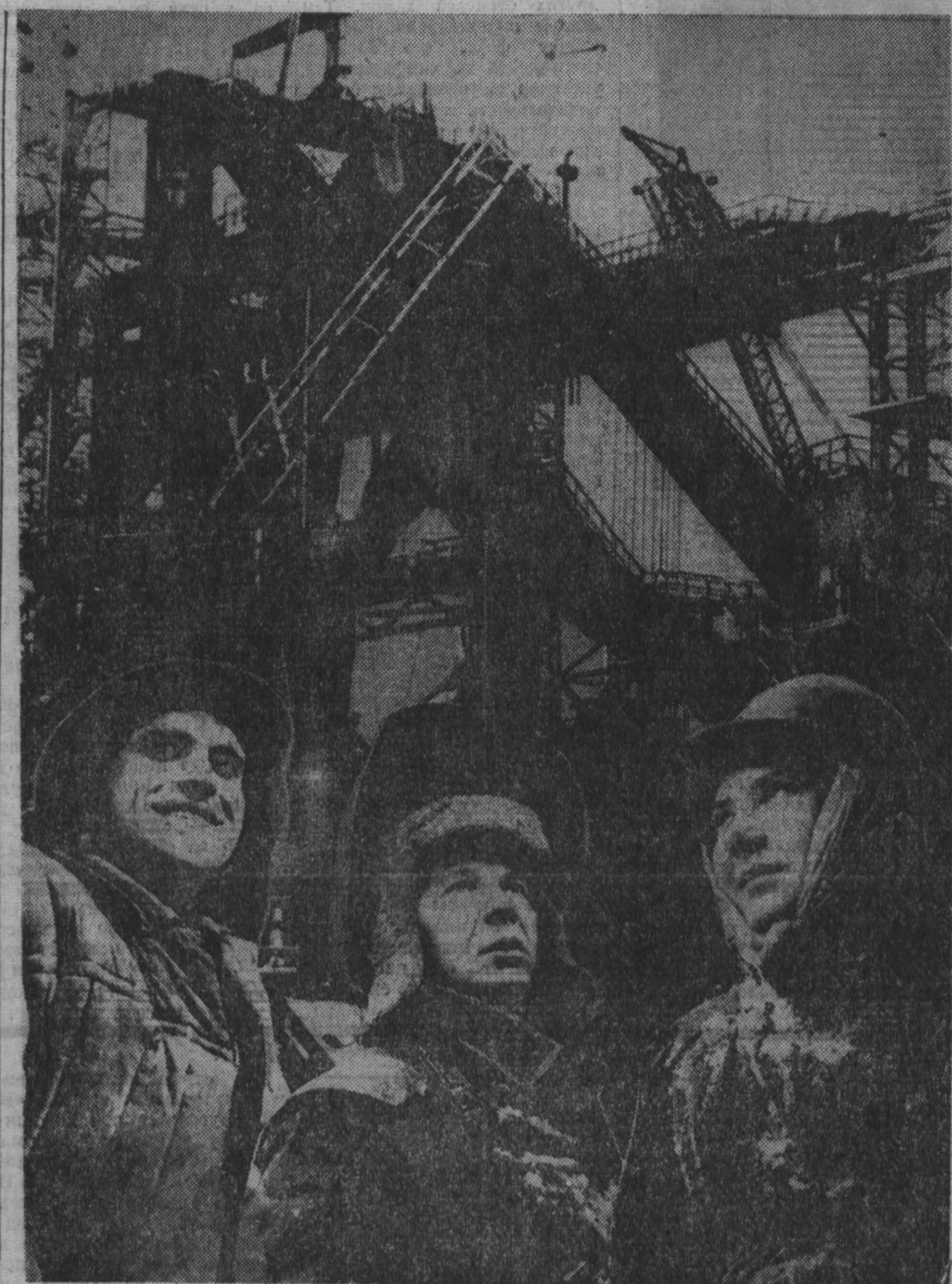
НА СНИМКЕ участники строительства третьей доменной печи Запсиба (слева направо): бетонщик В. Васильев, электросварщик И. Цвезев, изоляционныйщик Л. Чабан. Фото В. Воронина.
