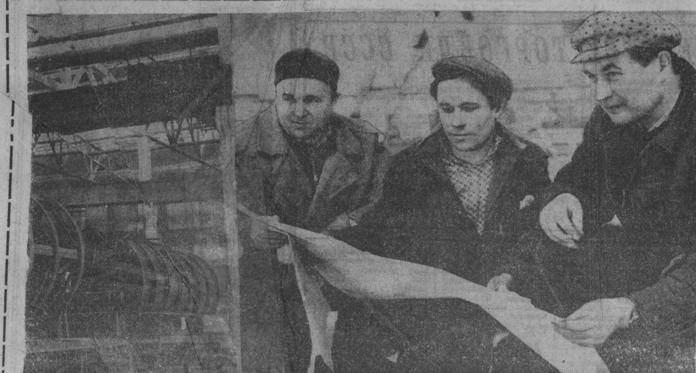
На Новокузнецком заводе технологических металлоконструкций и трубных заготовок вступила в строй первая очередь цеха рулонно-резервуарных металлоконструкций. НА СНИМКАХ: сварочные станы; лучшие слесари-сборщики цеха (слева направо) Ю. Малышев, И. Софрин и П. Стародумов. Фото Р. Нефедьева.
