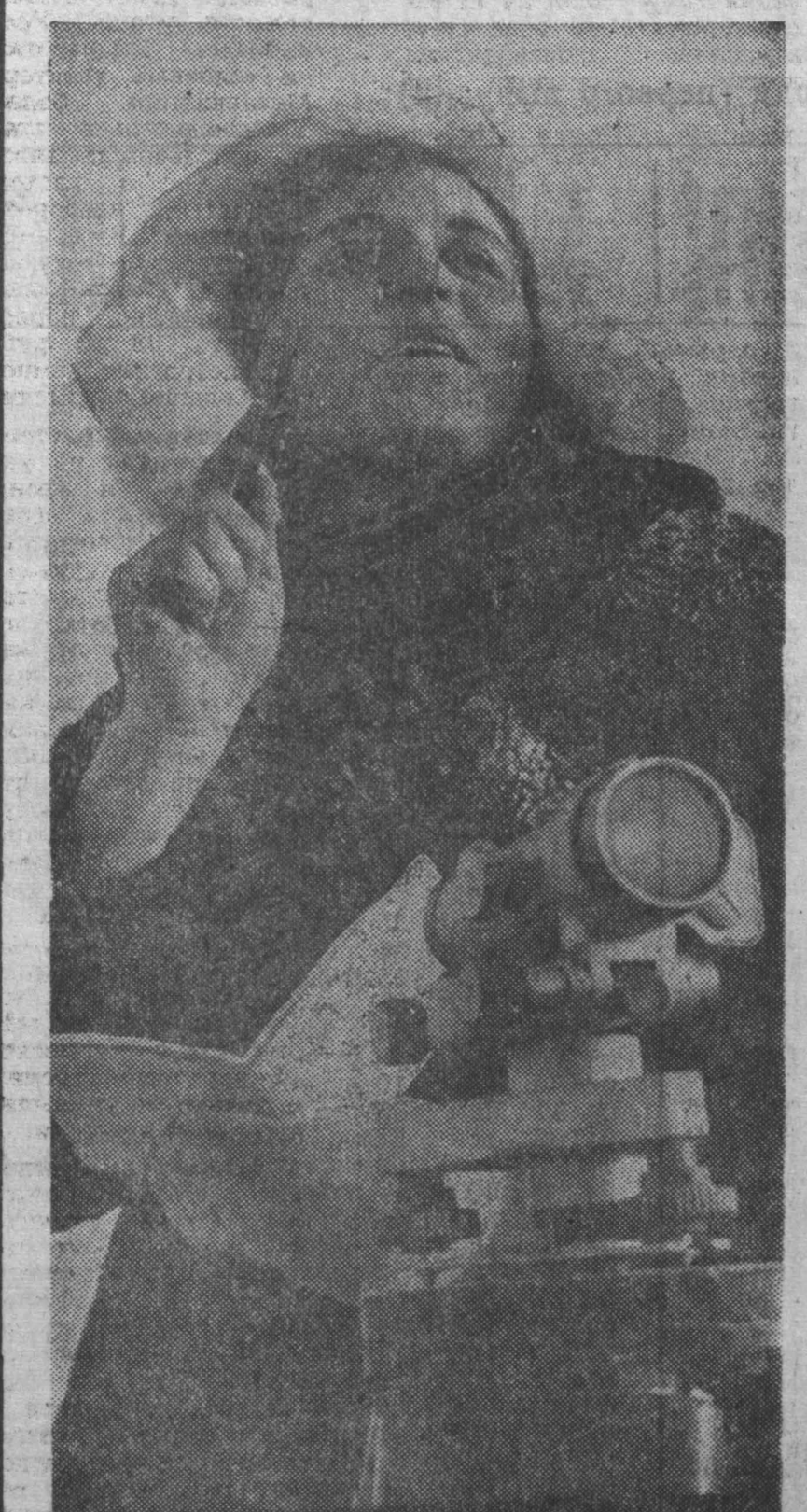
ГЕОДЕЗИСТ Галина Дергунова работает в строительном управлении № 3 треста «КемеровоХимстрой». Галина закончила Кузбасский политехнический институт, а свой трудовой путь строителя успешно начала два года назад с монтажа высотных зданий в Кемерово. Сегодня ее работа — геодезическая разбивка и проверка правильности установки панелей крупнопанельных зданий. Фото В. Грызыкина. г. Кемерово.
