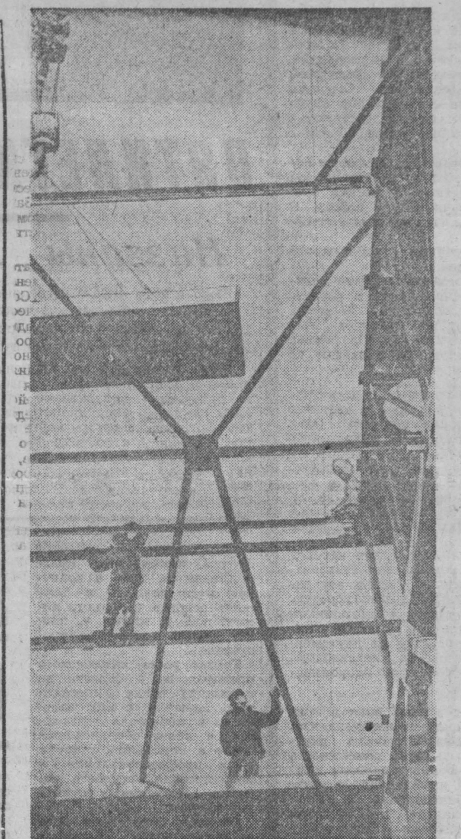
Бригада монтажников Владимира Николаевича Петрова ведет монтаж световой части пролета на главном корпусе Прокопьевского фарфоро-фаянсового завода.
