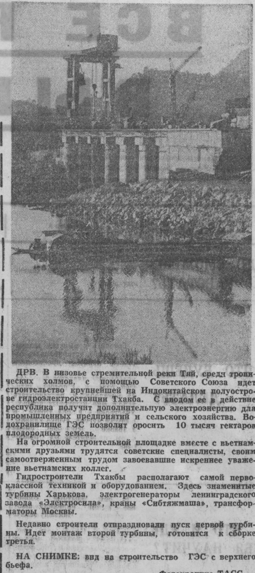
ДРВ. В нивозе стремительной реки Тей, среди горных холмов, с помощью Советского Союза идет строительство крупнейшей на Индонезийском полуострове гидроэлектростанции Тхаба. С вводом ее в действие республика получит дополнительную электроэнергию для промышленных предприятий и сельского хозяйства. Водохранилище ГЭС позволит оросить 10 тысяч гектаров плодородных земель.
