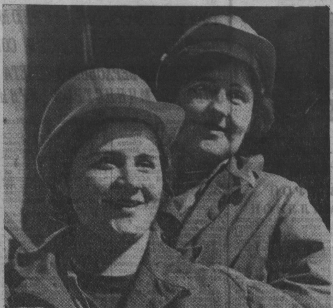
Капралакам третьей очереди — цусковой комплекс этого года на Новокемеровском химическом комбинате. Сейчас на стройке хозяйничает изолирующая треста «Сибтеплоизоляция».
