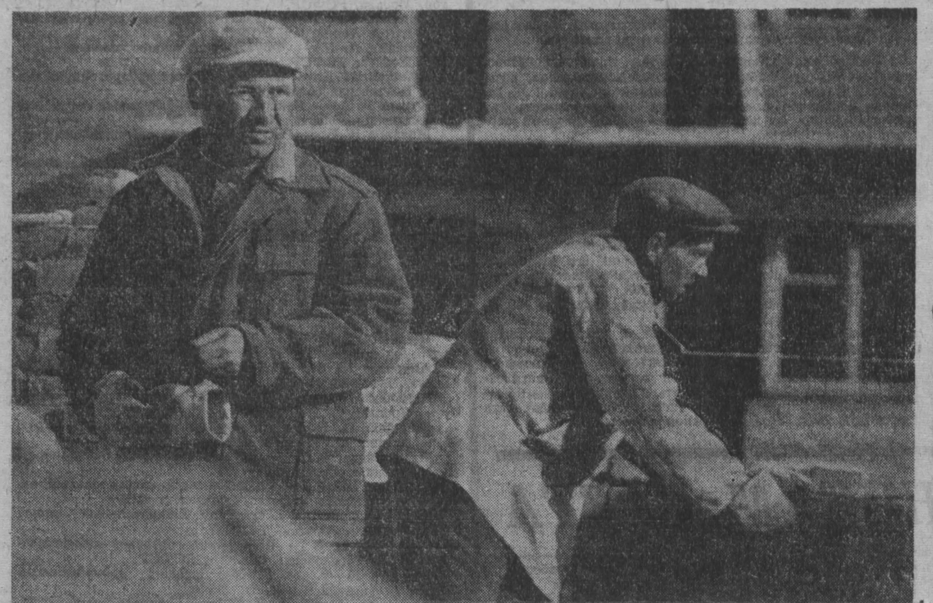
И. Ивановский руководит комсомольско-молодежной бригадой каменщиков второго строительного управления треста «Кемеровожилстрой».
