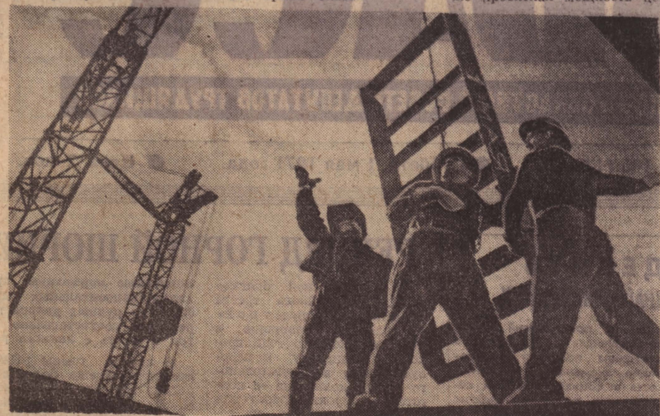
Бригада Юрия Обрезкова из второго управления треста «Сибстальконструкция» на монтаже галерей для транспортировки угля к коксовым батареям. Конверторный цех. Равис Нургалеев (на переднем плане) и Николай Куликов, помощник машиниста дистрибутора на трудовой смене.
