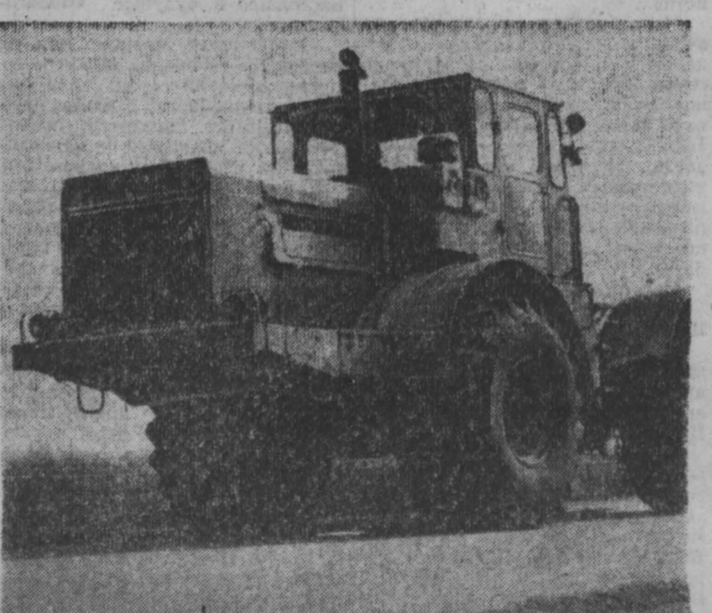
ЛЕНИНГРАД. Недавно государственная комиссия приняла модель трактора «И-701» и рекомендовала Кировскому заводу выпустить опытный партию этих машин для проведения эксплуатационных испытаний. Новая модель трактора-исполнителя отличается от предшествующих более мощным двигателем — в 283 лошадиных сил и рядом усовершенствований. Это позволило значительно увеличить тягу машины на крюке, улучшить ее динамику. НА СНИМКЕ «И-701».
