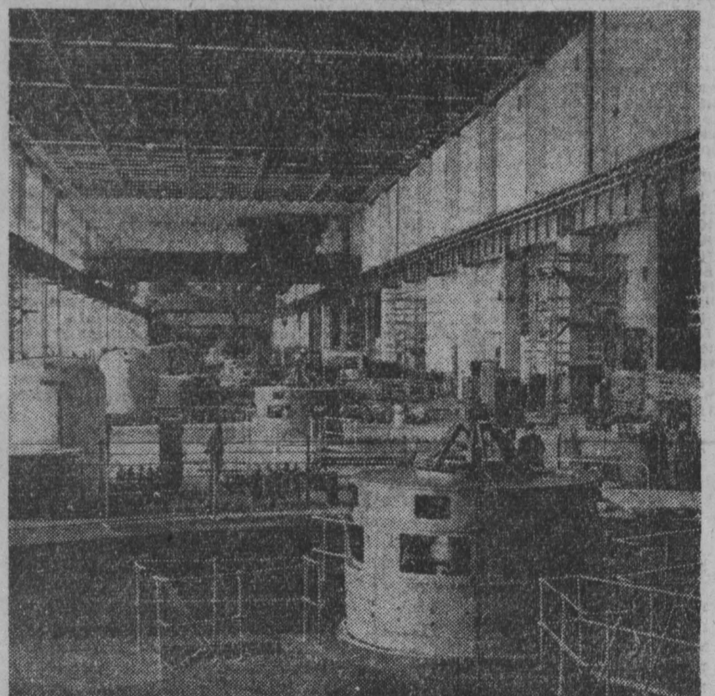
СТРОИТЕЛИ крупнейшей в мире Красноярской ГЭС смонтировали и подготовили к пуску десятый агрегат. Решено ввести в эксплуатацию дополнительно еще два агрегата — одиннадцатый и двенадцатый. Мощность гидроэнергетического гиганта на Енисее составила 6 миллионов киловатт.
