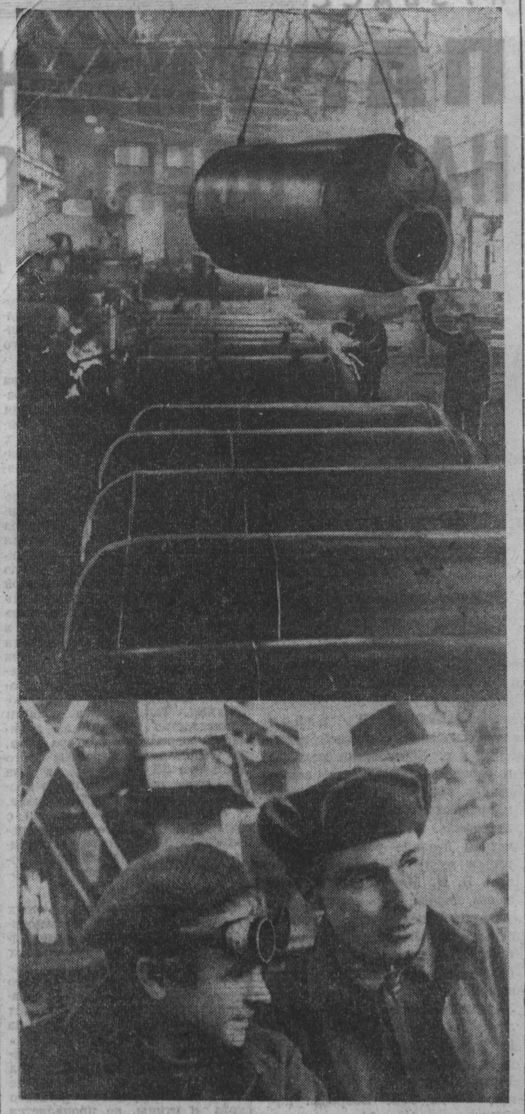
На снимках: газорезчик Александр Гайбич и бригадир слесарей Василий Савченко; котельно-сварочный цех. Фото В. Воронина. г. Новокузнецк.
