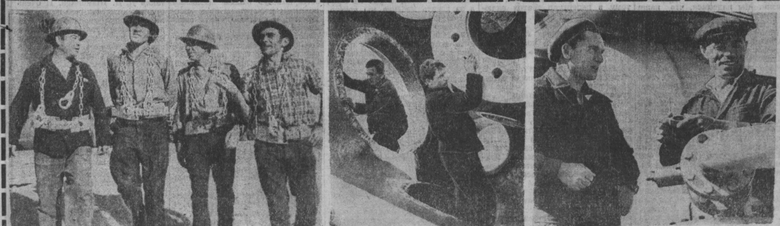
● ТУРКМЕНСКАЯ ССР. Недалеко от города Мары на берегу Каракумского канала раскинулась огромная строительная площадка. Здесь сооружается крупнейшая в Туркмении электростанция. Мощность нового энергетического гиганта превысит 1 миллион 350 тысяч киловатт. ● ЛЕНИНГРАД. За годы пятилетия машины Металлического завода имени XXII съезда КПСС оснащены стран. НА СНИМКЕ: сборщик Василий Будыко (слева) и Николай Власов (справа) на станциях Джердан—Железные Ворота. ● ТАТАРСКАЯ АССР. Каждые сутки инки республики приняли повышенные социалистические обязательства в честь 25-летия. НА СНИМКЕ: мастер добычи нефти из Альметьевска Зуфар Рамазанов (слева) и старший оператор Рашх Ахметшин на новой групповой установке. Коллектив, руководимый опытным нефтяником, дал стране с начала года около 4 тысяч тонн «черного золота» сверх плана.
