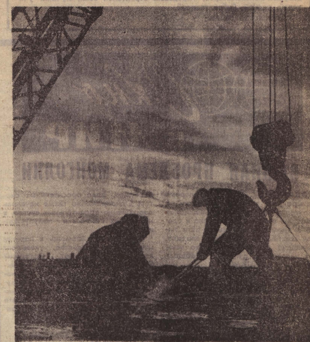
РЕМОНТО-механические мастерские треста «Ленинск-шахтострой». Монтажные работы ведут электросварщики бригады Виктора Подколызина из Кузнецкого строительного управления.
