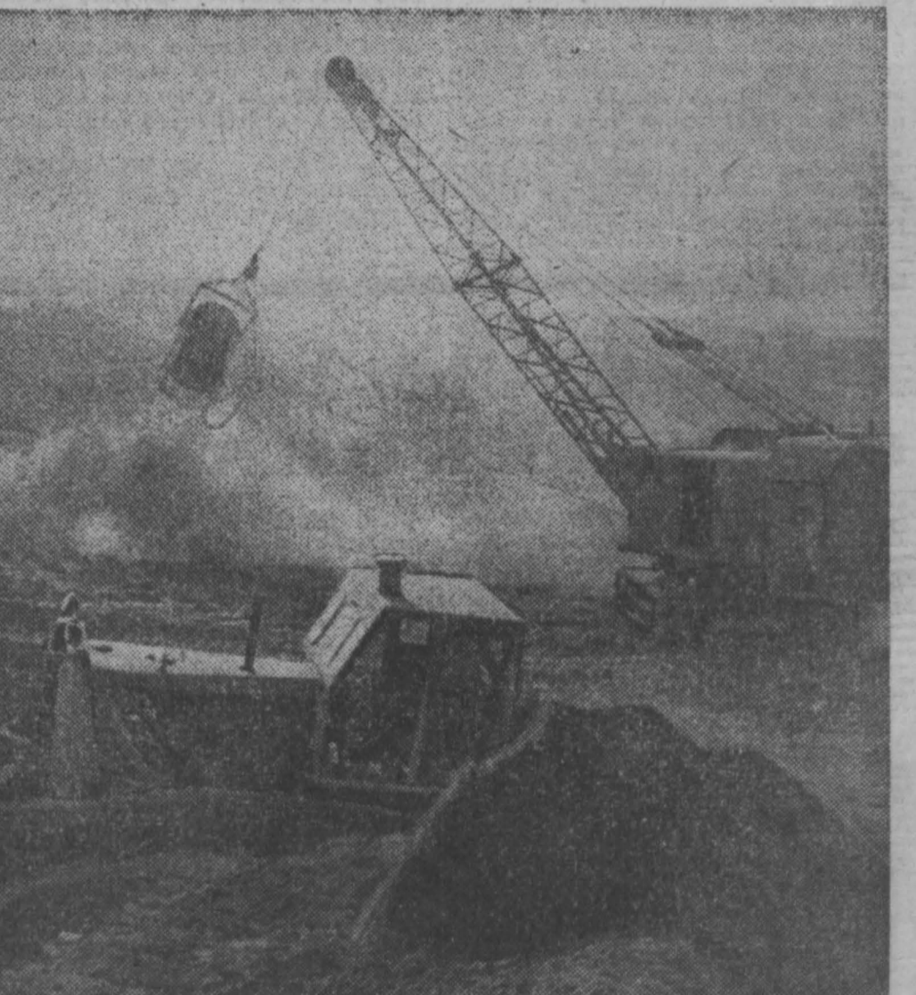
ЧИМКЕНТСКАЯ ОБЛАСТЬ. Напряженная работа в Кызылкуме. Эскаваторщики, бульдозеристы, скреперисты сооружают здесь канал протяженностью 105 километров, его пропускная способность будет 200 кубических метров воды в секунду.
