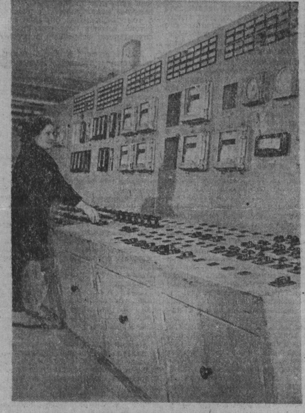
НА СНИМКЕ: главный шит управления химводоочистки, Аппаратчица М. Е. Колтомиц следит за показаниями приборов.
