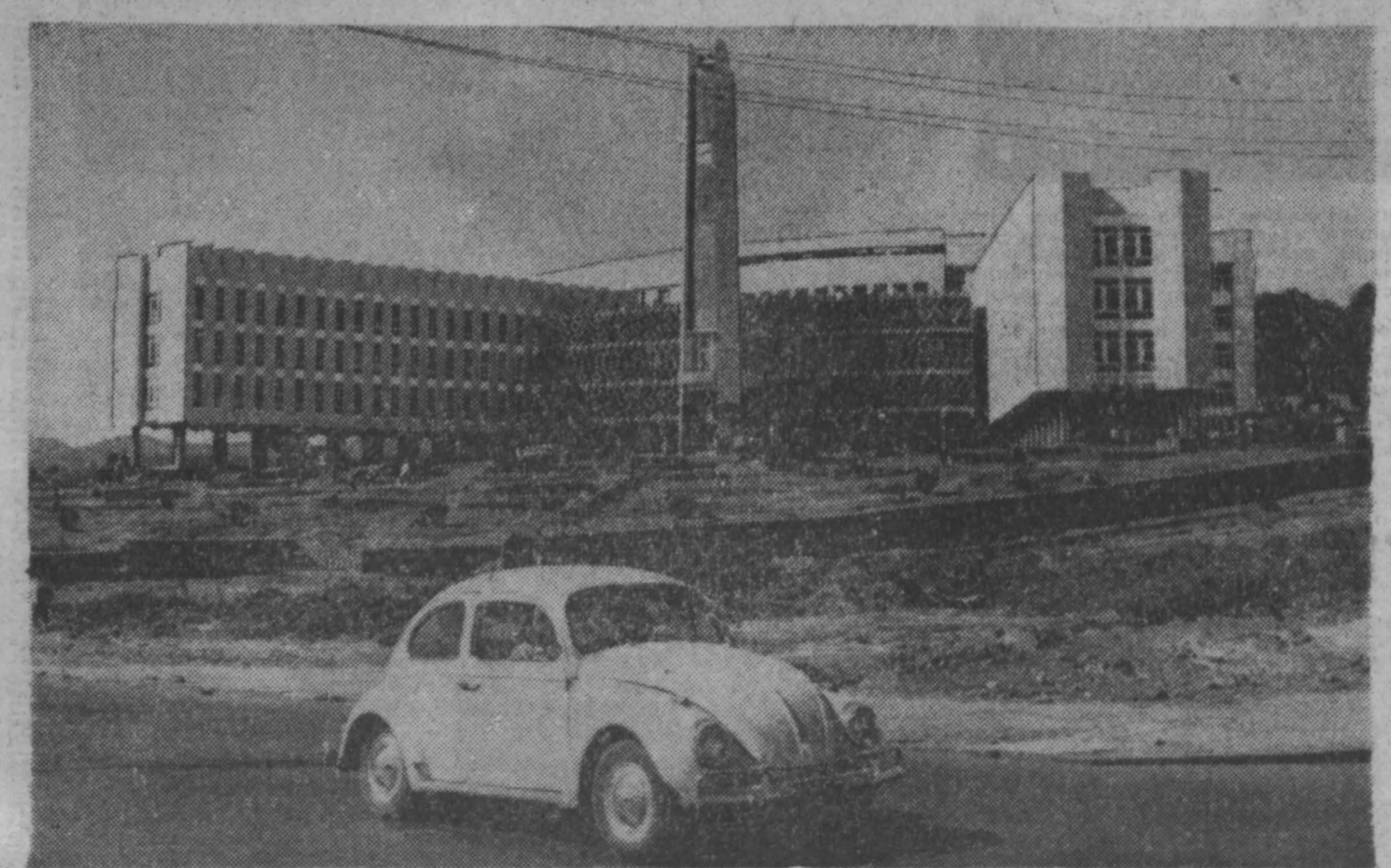
Эфиопия. Новое здание городского муниципалитета в Аддис-Абебе. Фотохроника ТАСС.
