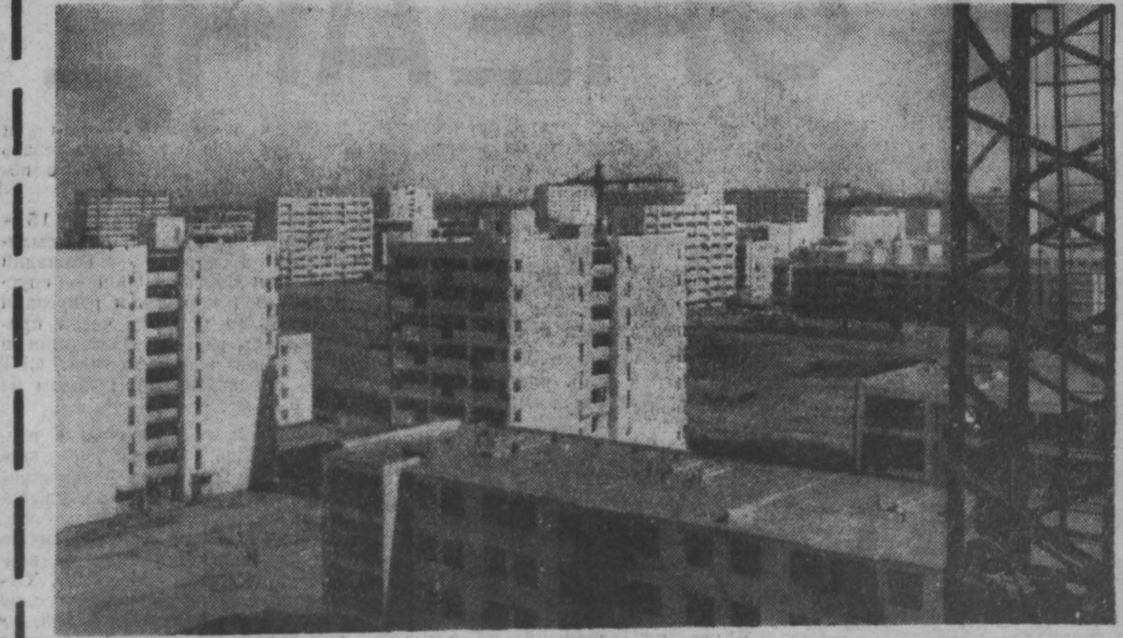
ТАШКЕНТ. Десятиэтажные дома становятся привычными в городском пейзаже. Их уже возведено более пятидесяти. Таких зданий много в районе старой глинобитной «Кашгарки», по которой пришла наибольшая удар подземной стихии. Эпицентр землетрясения находится самым «высоким» районом Ташкента.
