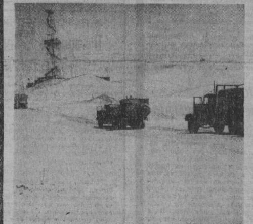
ТУРКМЕНСКАЯ ССР. Пятинадцатую по счету плавовую голубую топливную в песках Восточной Туркмении открыли буровики треста «Туркменнефтегазвед». При спробовании пробуренных в урочище Метеджан четыре глубоких скважины одна из них дала газовый фонтан, поднимающийся с глубины 2724 метра. Первая перспективная скважина Метеджана в настоящее время дает свыше 370 тысяч кубометров газа в сутки. Работы по испытанию газовых пластов продолжаются.
