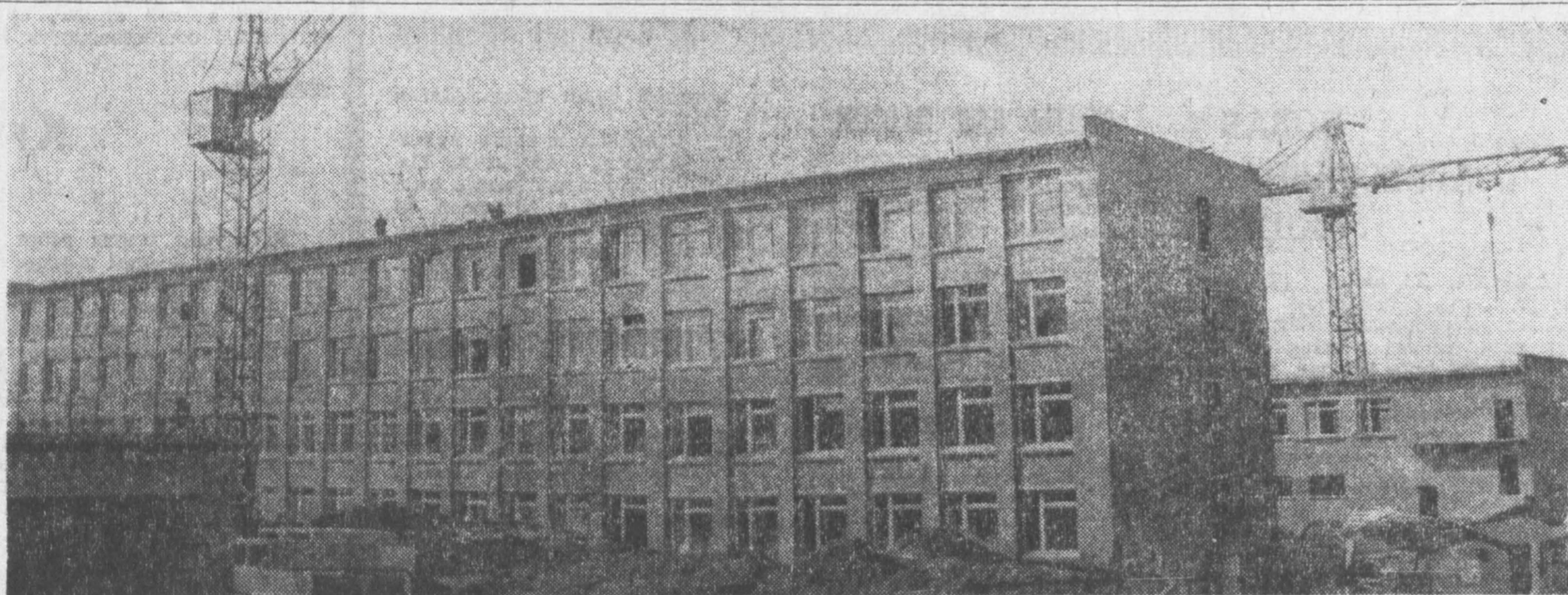
Все ближе город подступает к Суховскому озеру. Вот и в микрорайоне № 9 полным ходом идет строительство жилья. Тут же возводится политехническая средняя школа. Стройку ведет коллектив строителей треста «Кемерово-Промстрой».
