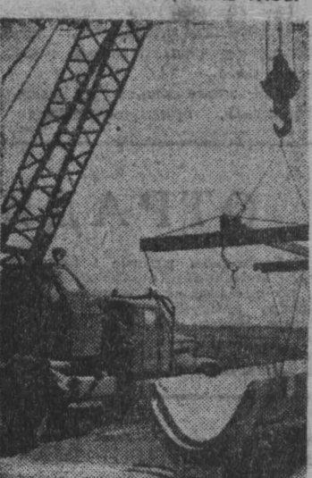
Азербайджанская ССР. Большие работы по комплексной механизации земельных участков совхоза М в Елаханском районе. Вспомогательная техника, техника «Ура-Архангельск». Впереди в разрезе видна система закрытой дренажной сети и лоточная система орошения. НА СНИМКЕ: укладка железобетонного лоточного канала. Фотохроника ТАСС.
