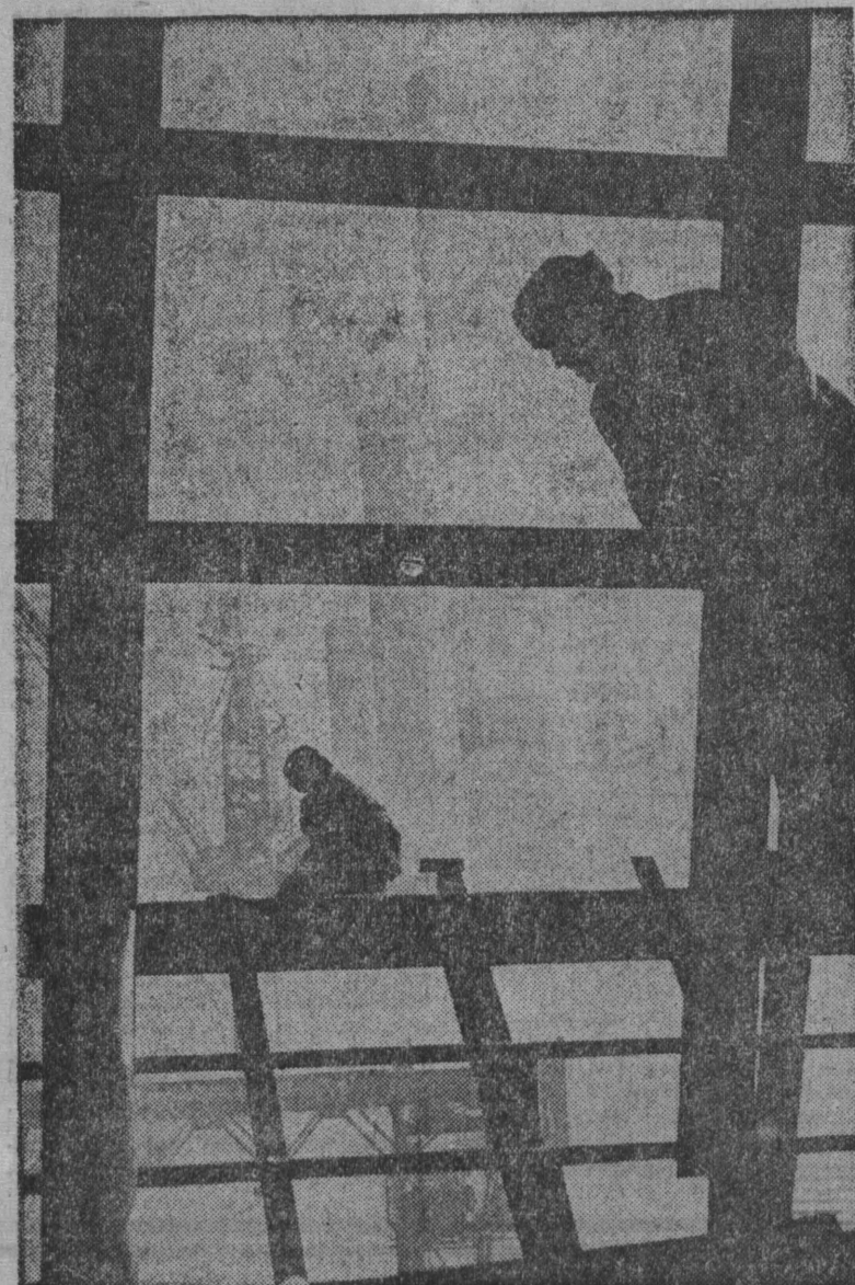
Заканчивается сооружение одной из крупнейших электростанций в Кузбассе — Беловской ГРЭС. В конце этого года войдет в строй последний, шестой энергоблок. А сержанты-строители и монтажники несут преданную трудовую вахту.
