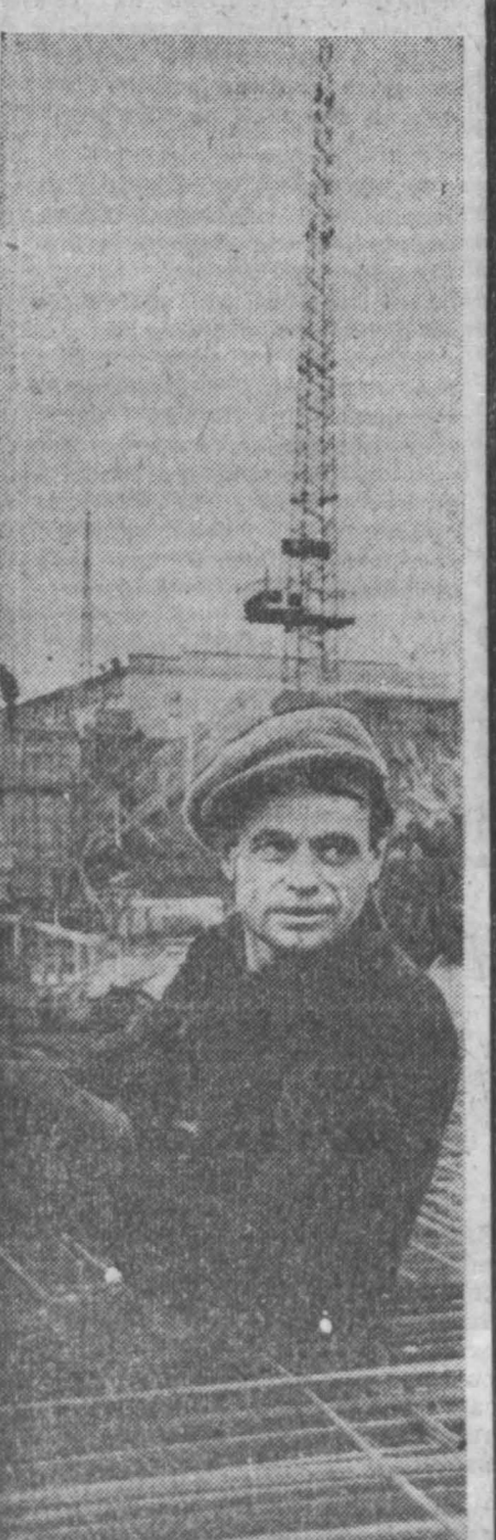
В комсомольско-молодежной бригаде имени 50-летия Великого Октября, которой руководит Александр Козлов, безупречно трудятся на подготовке фундаментов для «сборки» блочинга — махила ветеран стройки Запорожской атомной электростанции СУ-5 треста «Узэнергопроектстрой» Иван Жигалин. Он ежедневно выполняет норму и добивается отличного качества работы. НА СНИМКЕ И. Жигалин. Фото В. Дунаева.
