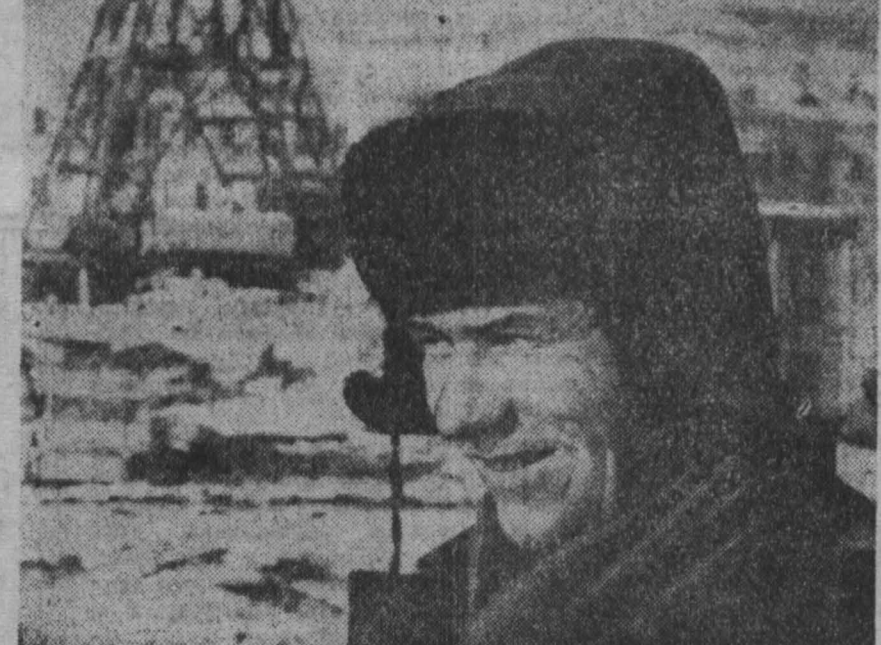
Монтажник СУ № 9 треста «Кузнецкинстрой» Кирилл Яковлевич Черданцев 18 лет строит дома в городе металлургов. Бригада, в которой он работает, ежедневно выполняет план монтажных работ на 150—160 процентов.
