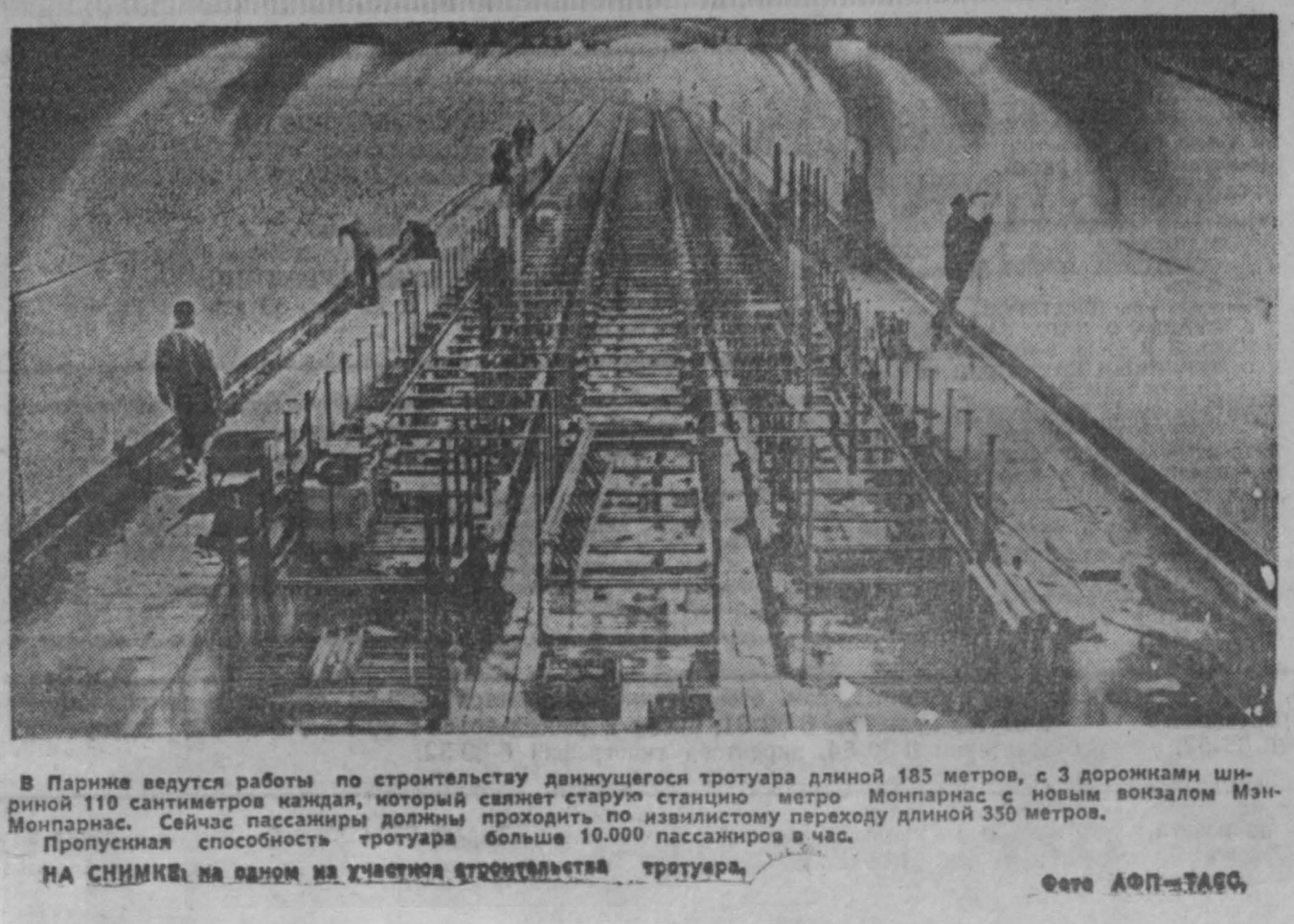
В Париже ведутся работы по строительству длившегося тротуара длиной 183 метров, с дорожными ширинами 110 сантиметров каждая, который соединит старую станцию метро Монпарнас с новой вокзалом Монпарнас. Сейчас пассажиры должны проходить по извилистому переходу длиной 350 метров.
