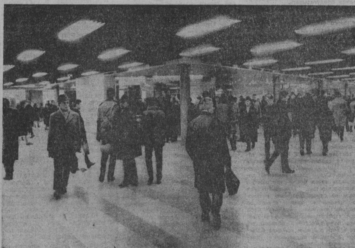
Жители Праги получили от строителей хороший подарок. Первый в чехословацкой столице подземный переход, оборудованный эскалаторами, начал действовать в самом центре города на Вацлавской площади. Размер подземного зала 3,5 тысячи квадратных метров. Здесь разместятся киоски с газетами и сувенирами, витрины с образцами товаров столичных магазинов. Со вкусом и умением украсили переход художники-декораторы и осветители. На снимке: подземный зал.
