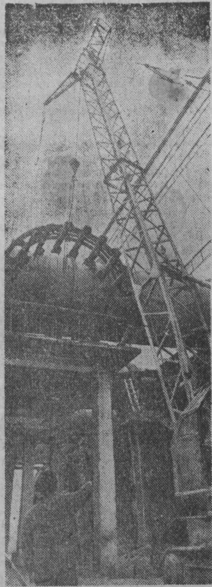
Бирюлинская ЦОФ — пусковая стройка этого года: строители и монтажники готовят объекты к сдаче. Сейчас бригада Л. Х. Камбура ведет монтаж сушильных барабанов.
