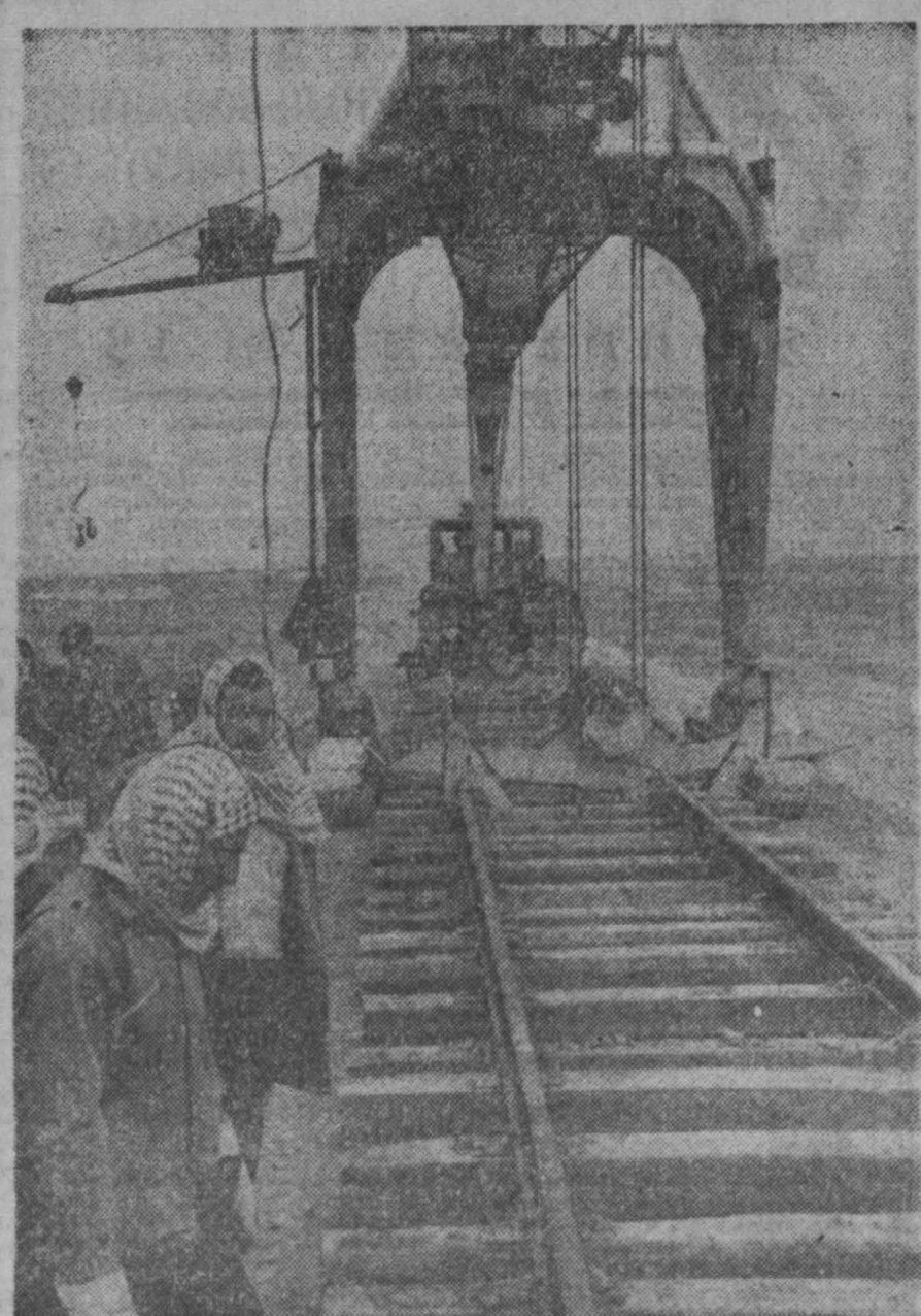
СИРИЙСКАЯ АРАВСКАЯ РЕСПУБЛИКА. На строительстве новой железной дороги Латакия — Алеппо — Камышлы протяженностью 712 километра хорошо зарекомендовали себя советские путеуладники, с помощью которых опытные строители совместно с советскими инженерами и техниками прокладывают 1.500 метров железнодорожного пути за смену.
