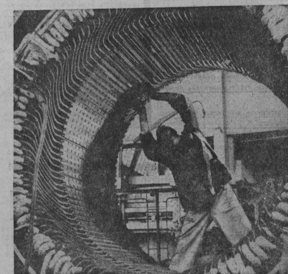
Далеко вперед шагнула за годы народной власти Болгария в своем индустриальном развитии. На снимке: монтаж статора на машиностроительном заводе в Софии.
