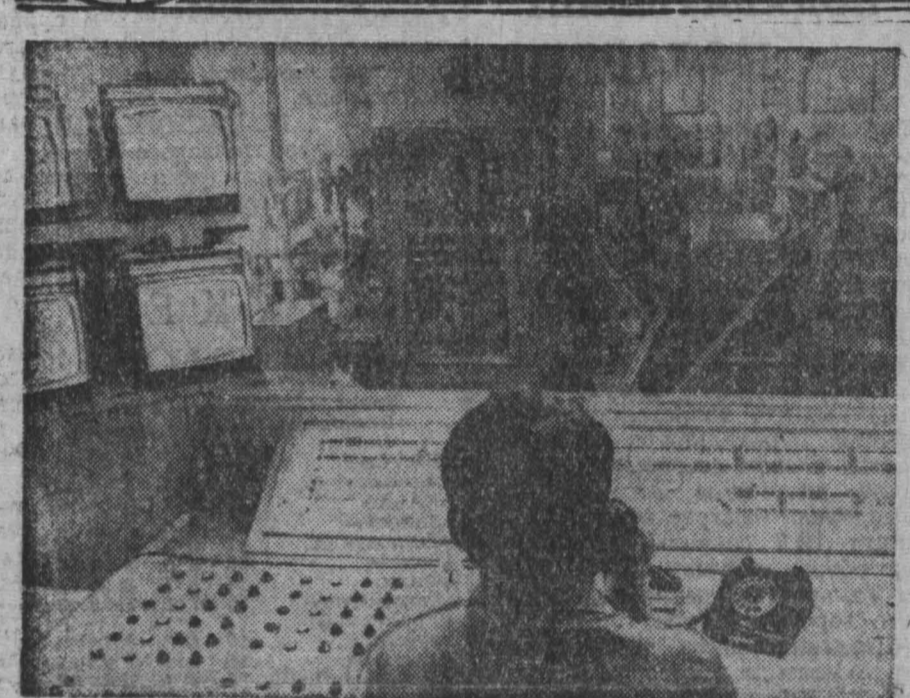
В Руле — на известном часе, все предприятия Тамбовской области работают в режиме широкого применения промышленного телевидения. С центрального пункта управления (на снимке) контролируется весь сложный автоматизированный процесс изготовления корпусов, электроизоляции, химической очистки и гальванической обработки поверхности.
