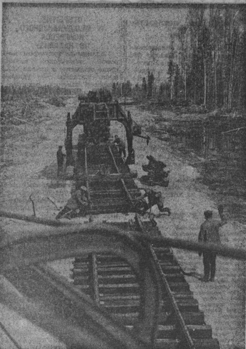
ТОМСКАЯ ОБЛАСТЬ. Здесь строится железнодорожная магистраль Асено — Байкал. 184-километровая гряда пройдет через вековую нарышную тайгу, реки, болота. Подравнину эксплуатация уже дано 85 километров пути.
