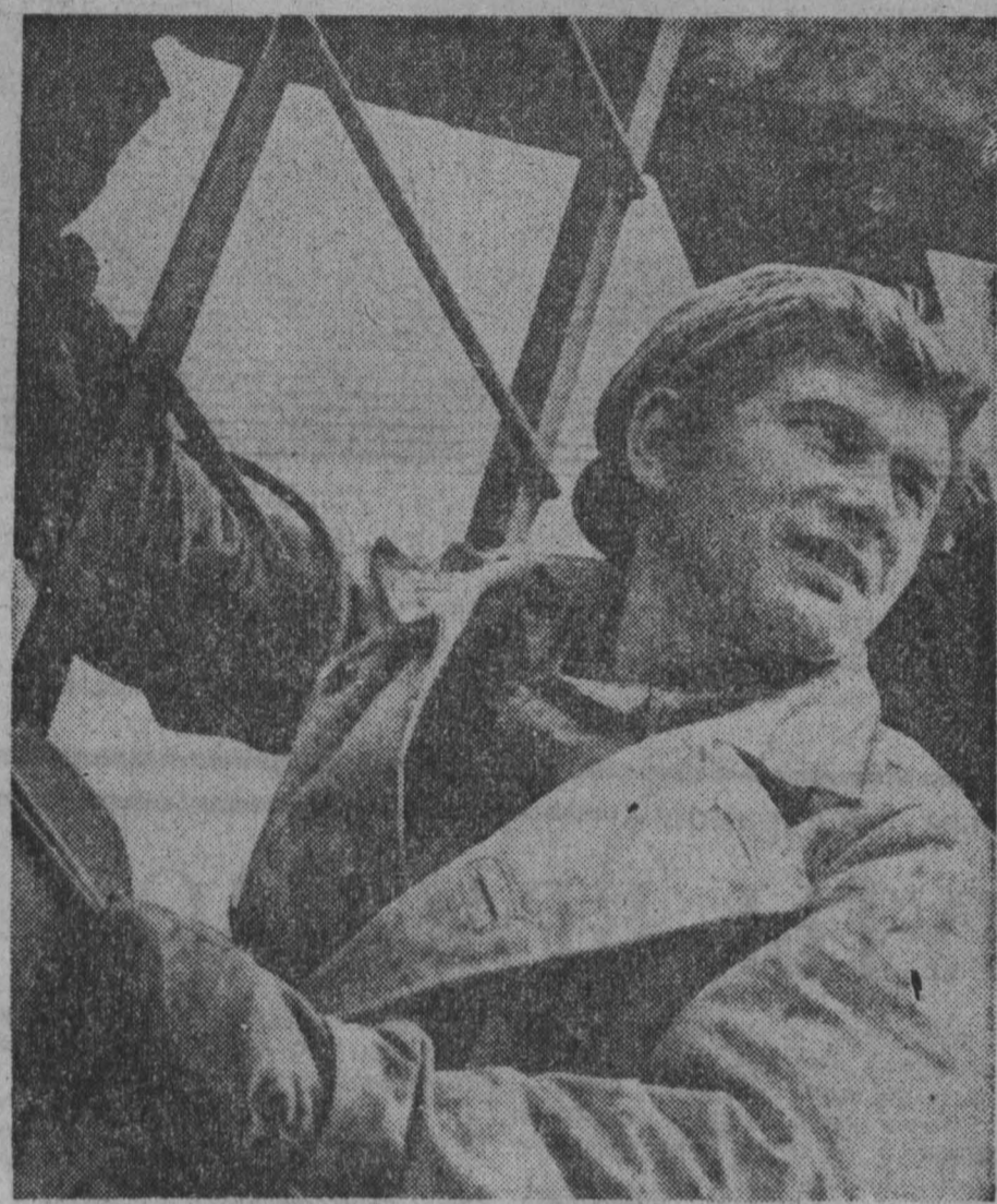
Метр за метром наращиваются трубы — идет монтаж теплопровода на конверторном цехе Запсиб. Здесь трудятся и электро-сварщики Запсибского управления треста «Сибметаллургмонтаж» Константин Ульянов. Он отличился в качестве специалиста. Сменные задания всегда выполняет на 120—130 процентов. НА СНИМКЕ: К. Ульянов.
