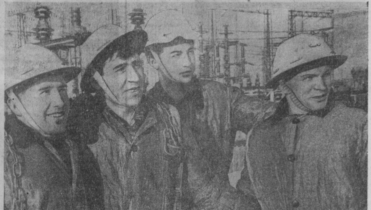
НА СНИМКАХ: Идет монтаж заградителя высокочастотной связи по линии ЛЭП-500. Работает бригада И. И. Твардовского. 24 года трудится на сооружении подстанции техник Нина Кондратьева Ефремова. Сейчас она руководит работами на подготовке цеха под вторую группу трансформаторов на Ново-Анжерской подстанции. Ремонтники электростанции (слева направо): электрослесари Виктор Абушев и Анатолий Агафонов, дежурный по подстанции Роман Муслимов и монтер службы перенапряжения и изоляции Альберт Ильин.
