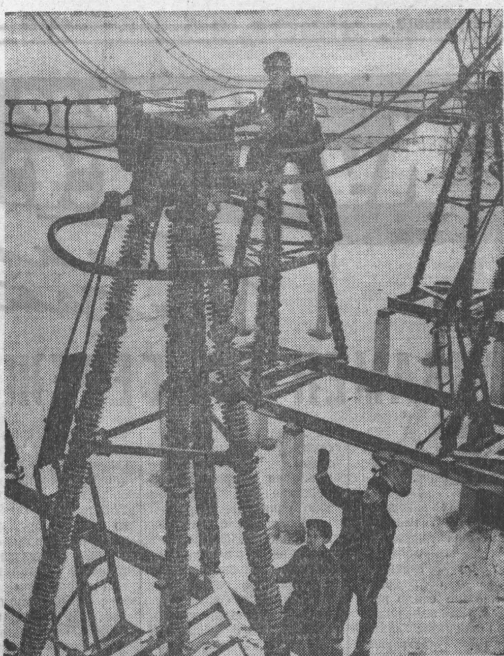
Ново-Анжерская электростанция на 500 киловольт. Идет монтаж электролинии. Фото П. Костюкова.
