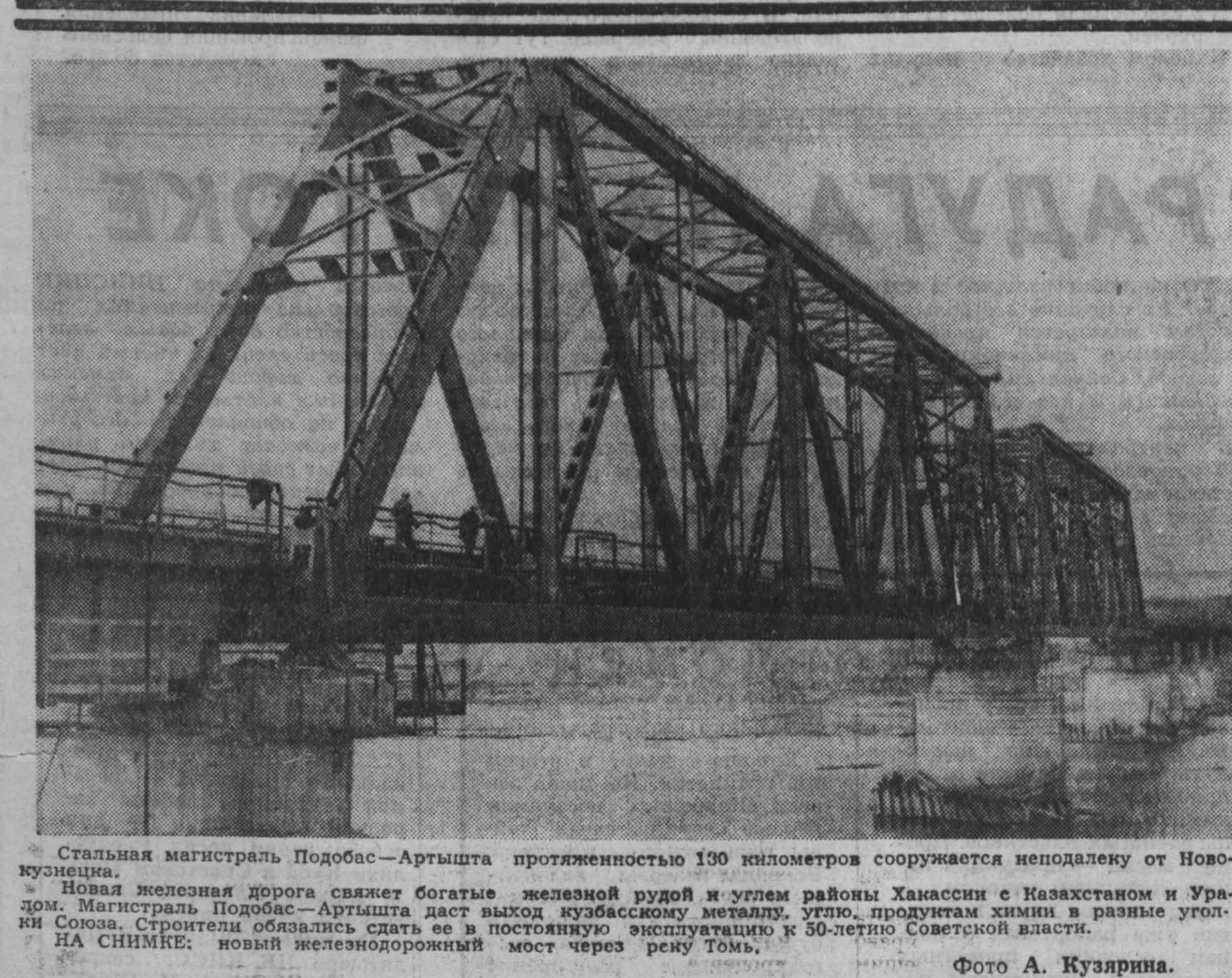
Стальная магистраль Подобас-Артышта протяженностью 130 километров сооружается неподалеку от Новокузнецка...
