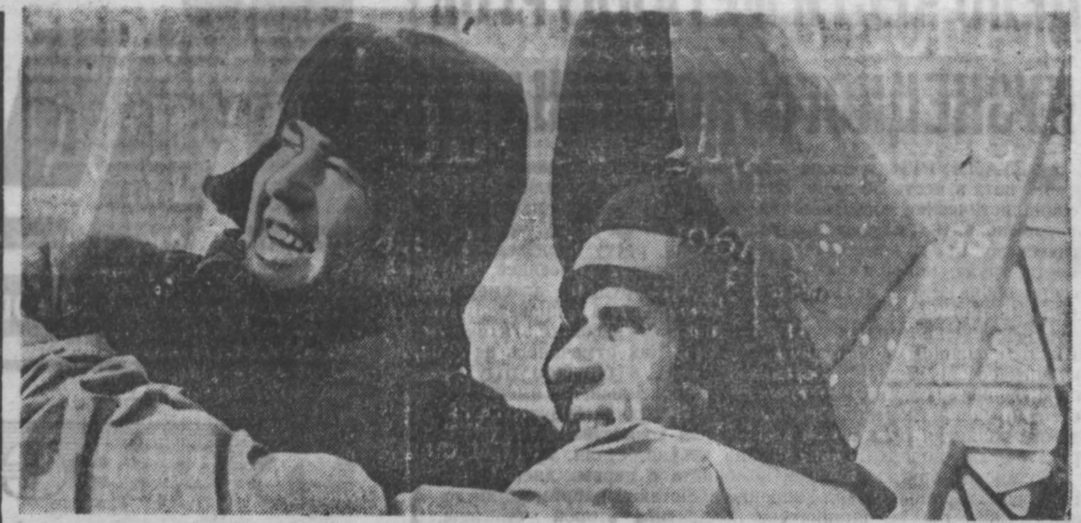
Монтажники Владимир Подберезкин и электросварщик Александр Фролов из строительного управления № 4 треста «Кузнецкинстрой» трудятся на сооружении нового жилого массива в 67-м квартале Новокузнецка. Их знают здесь как энергичных и трудолюбивых работников, систематически перевыполняющих дневные задания. НА СНИМКЕ: В. Подберезкин и А. Фролов. Фото В. Воронина.
