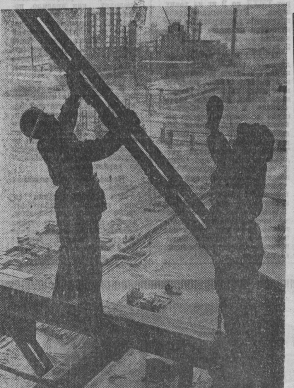
ЯРОСЛАВЛЬ. Полным ходом идет сооружение крупнейшего на территории страны гидроэлектростанции. Высота установки — самая большая на предприятии. Высота составляет 72 метра. В 1967 году нагнетательский кренинг начнет производство бензина самого высокого качества. Слесари-монтажники К. Баранов (слева) и Н. Фомины начали сборку кренинга на земле. Сейчас они работают на высоте 72 метра. Здесь иречь о морозе и злее ветер. Но рабочие выполняют свои задания на 120 процентов. ФОТОХРОНИКА ТАСС.
