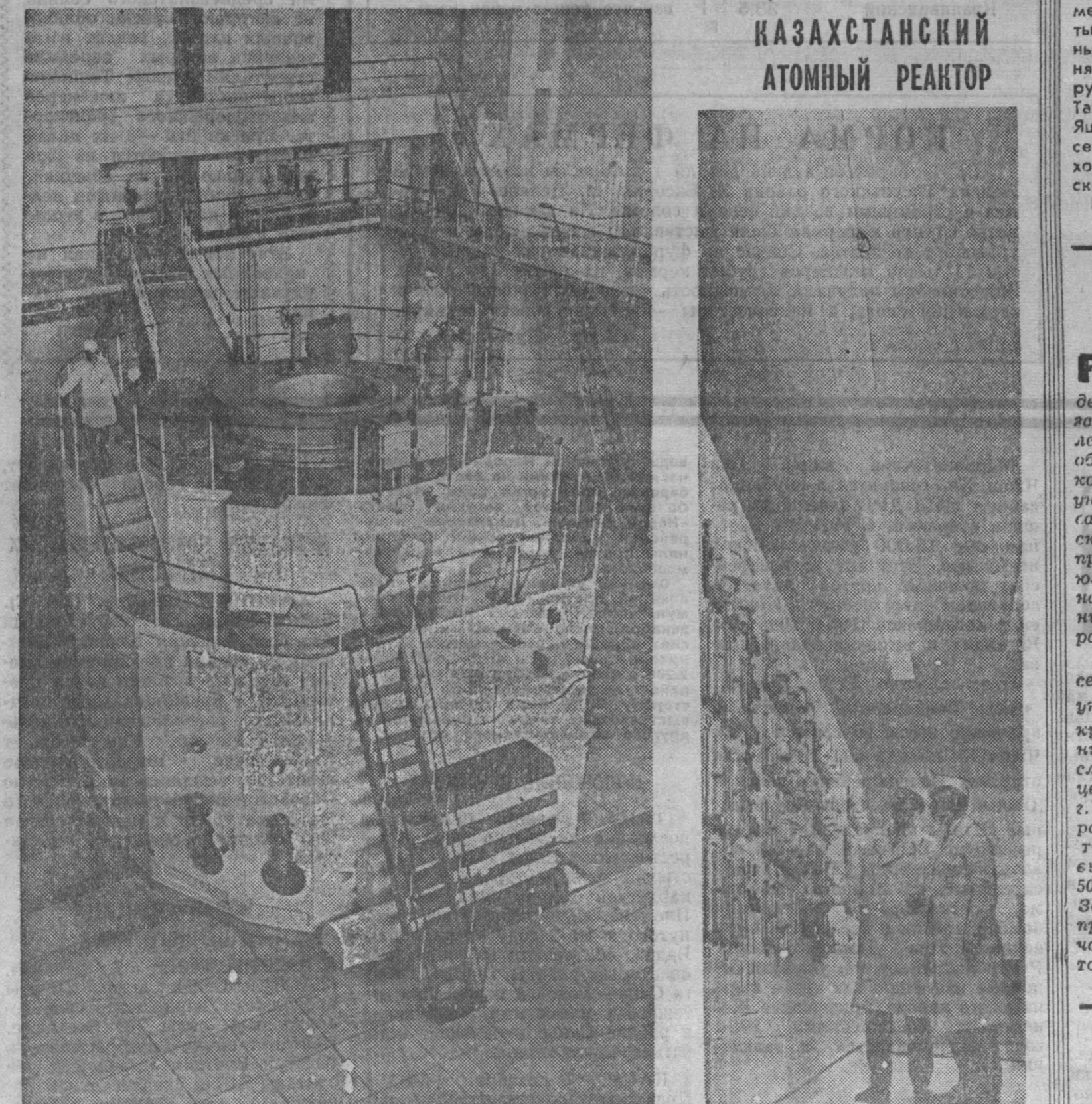
В Институте ядерной физики Академии наук Казахской ССР запущен в работу атомный реактор ВВР-1. Этот мощный источник радиоактивного излучения позволит ученым Казахстана вести большой круг научных исследований в области радиационной физики и химии, а также по радиобиологии. Замедлителем, отражателем и теплоносителем реактора служит обычная вода, а в качестве делящегося материала в аппарате используется обогащенный уран. НА СНИМКАХ: новый реактор, управление атомным реактором ВВР-1. Фото И. Вудинича, АПФ.
