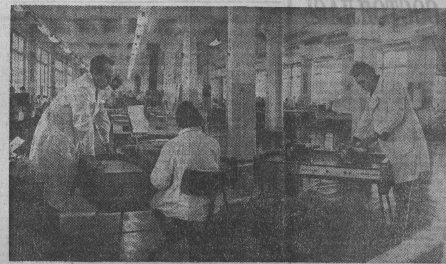
Новые электронные вычислительные машины для полиграфической промышленности, издательской страны выпускает один из томологических заводов. Электронная вычислительная машина программирует управление строкотрипной и фотонаборной машинами и тем самым автоматизирует наборные процессы в полиграфии. К серийному выпуску таких машин завод приступил недавно. В комплекте механизмов входит наборно-программирующее, моргерирующее и буквопечатающее устройства.
