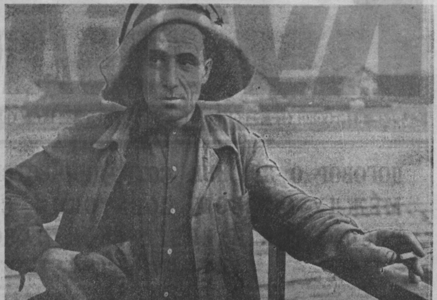
Начало рабочей биографии Кузнецкого комбината — это и начало трудовой жизни Павла Ефимовича Инюткина. Он строил завод — был землекопом, бетонщиком, бетонщиком, выполнял первый домик КИМ. А когда пекь подготовки и пуску — ушел на все горючие. С тех пор и трудился здесь. Коммунист П. Е. Инюткин недавно награжден партией орденом КИМ за 34 года реин металла выплавляемых его руками. Звезда Героя Социалистического Труда, три ордена Ленина, два ордена Трудового Красного Знамени на груди ветерана-доменина. Почетный металлист, заслуживший право на пенсию, орденом он с тех пор не уходит на отдых, передает опыт молодым. НА СНИМКЕ: П. Е. Инюткин.
